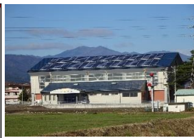
屋根貸しによる下平体育館への太陽光パネル設置
