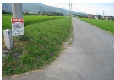
地域の要望により整備された生活道路
