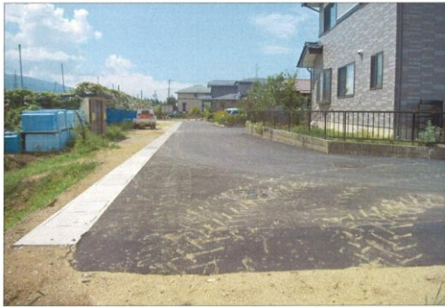
地域からの要望により道路側溝を整備し、水たまり対策を実施しました。
