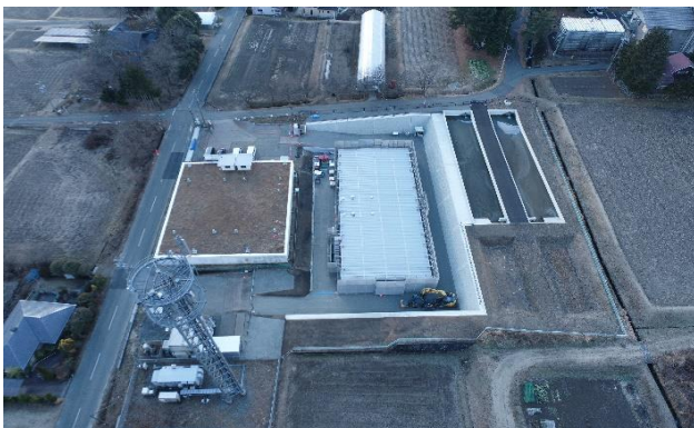
完成間近の切石配水池
