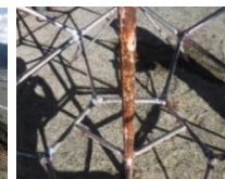
支柱の腐食
