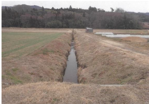
改修前の水路施設
