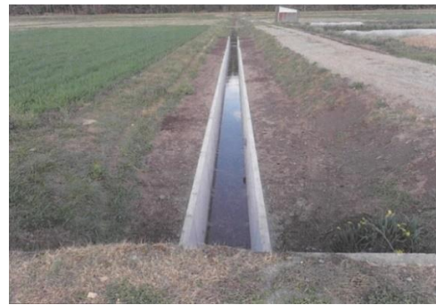
改修工事後の水路施設
