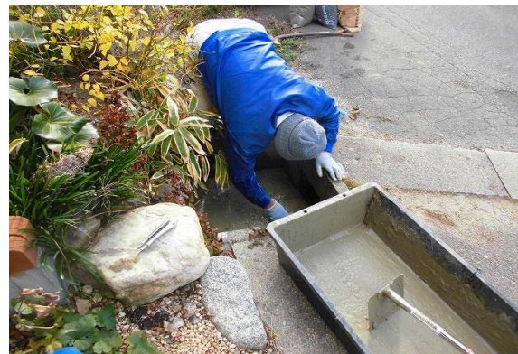
共同活動による破損した水路の修繕
