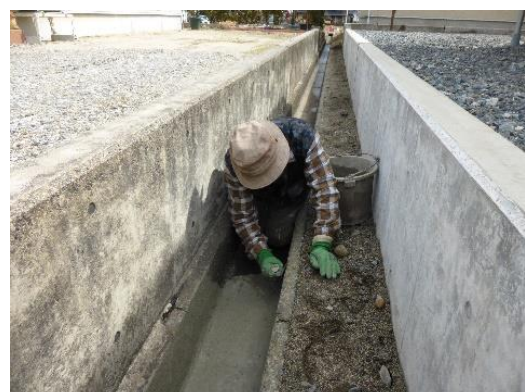
破損した水路の修繕
