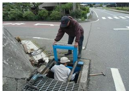
破損したゲートの修繕
