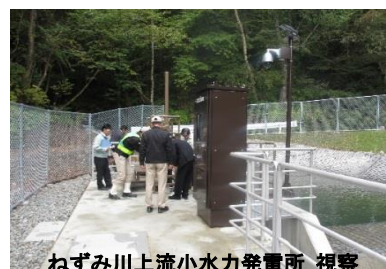
ねずみ川上流小水力発電所 視察
