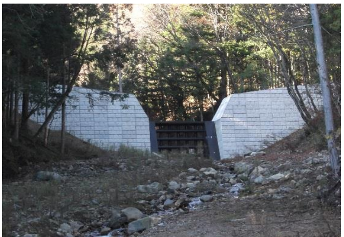
平成26年度完成した砂防えん堤 (上穂沢川)
