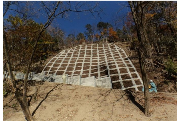
治山事業実施後
