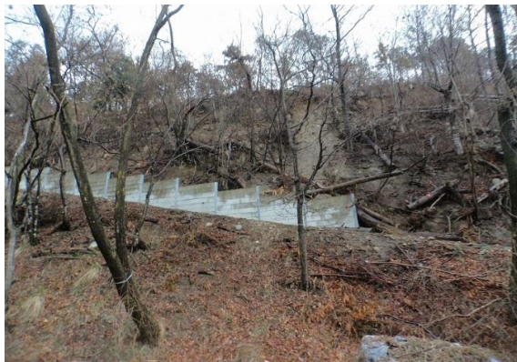
治山事業実施前
