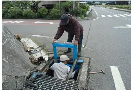
破損したゲートの修繕
