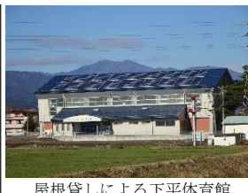
屋根貸しによる下平体育館への太陽光パネル設置
