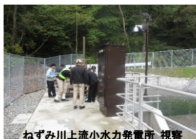
ねずみ川上流小水力発電所 視察
