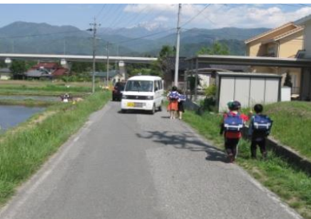
通学路に整備された歩道
