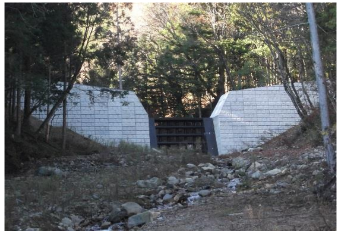
平成26年度完成した砂防えん堤 (上穂沢川)
