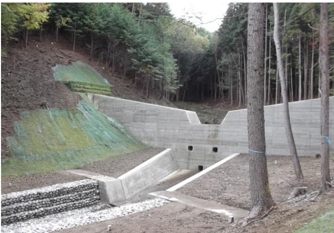
平成24年度完成した砂防えん堤 (下間川水系)
