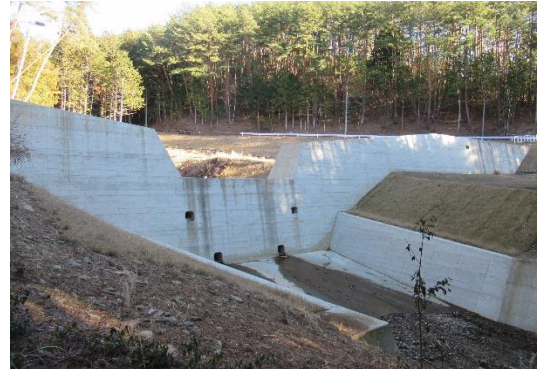
唐沢川砂防事業1号えん堤 (平成31年1月時点)
