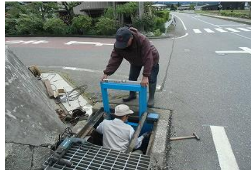
破損したゲートの修繕
