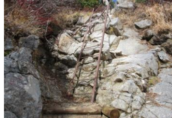
登山道整備(施工後)
