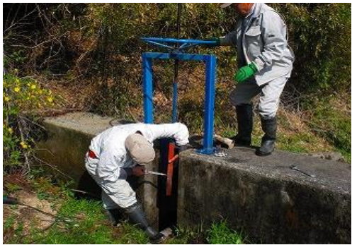
破損したゲートの修繕
