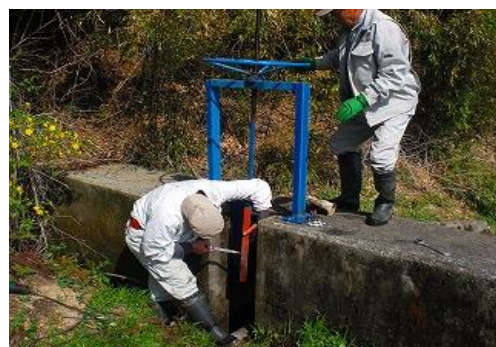
破損したゲートの修繕
