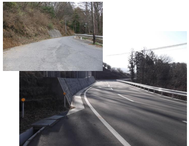
市道本曾倉線の整備
