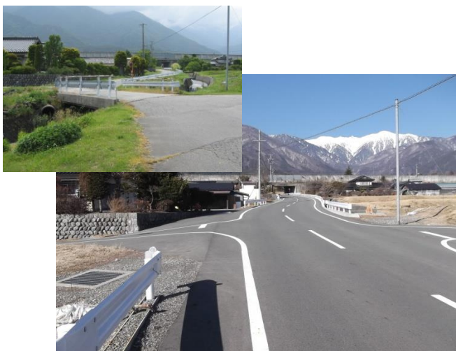
市道中割縦線の整備
