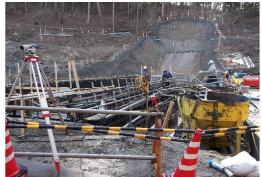
砂防えん堤建設状況（唐沢川）
