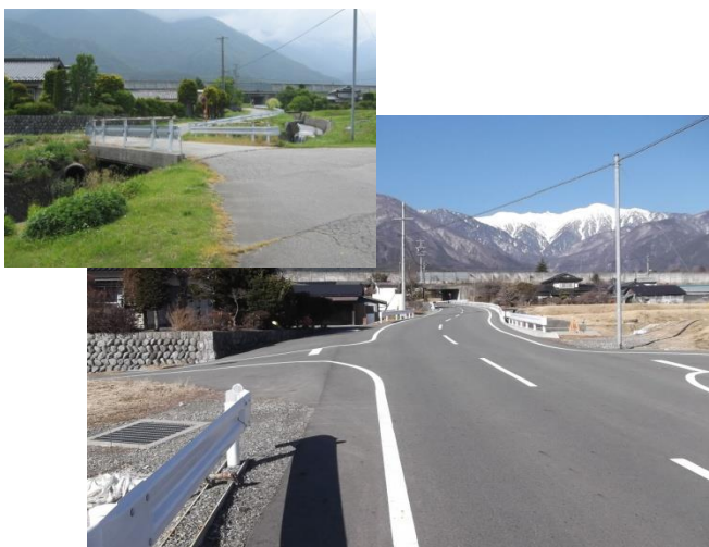
市道中割縦線の整備
