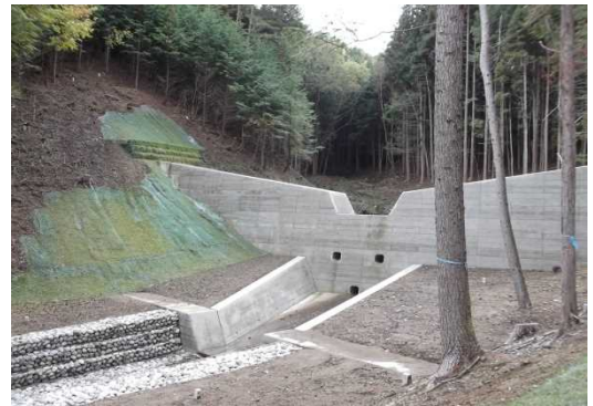
平成24年度完成した砂防えん堤 (下間川水系)
