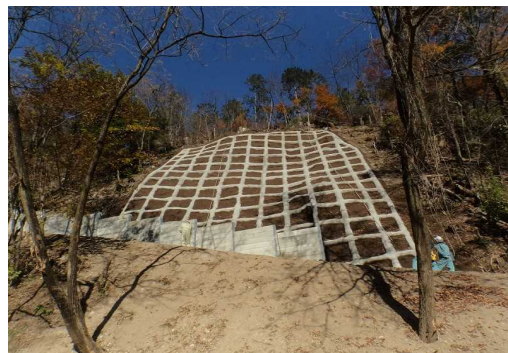
治山事業実施後
