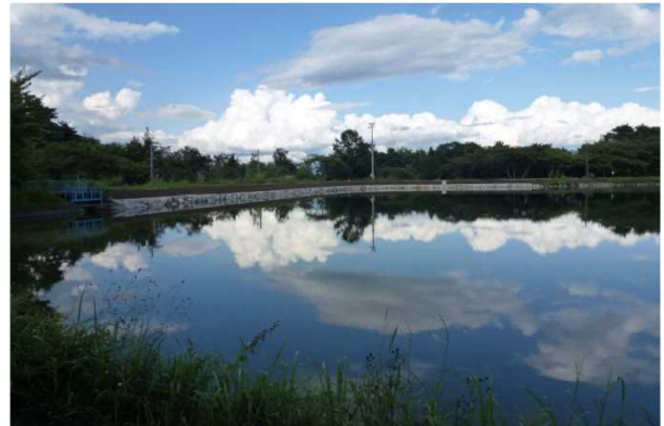
駒ヶ根池(改修後)
