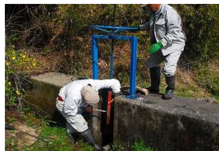
破損したゲートの修繕
