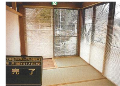
着付け部屋（改修後）
