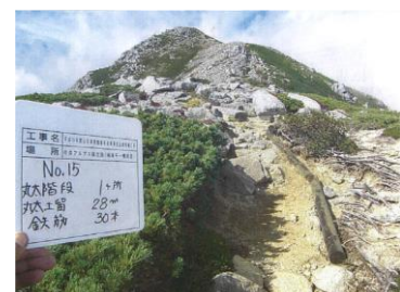
丸太土留設置
