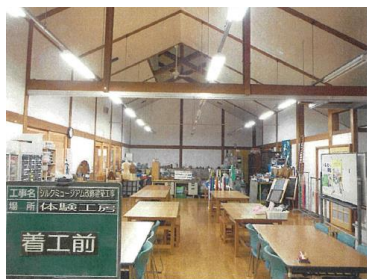
体験工房（室内）改修前
