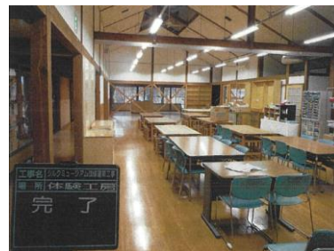
体験工房（室内）改修後
