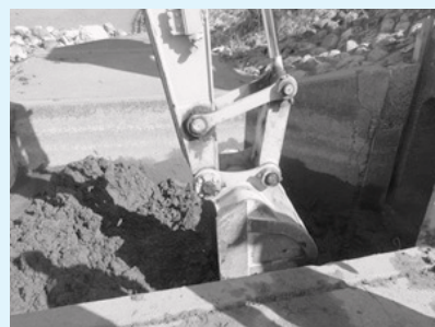
土砂で埋まる取水口を重機で除去
