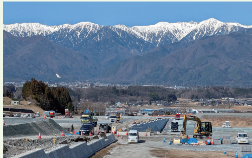
新宮川岸地区ほ場整備工事の様子
