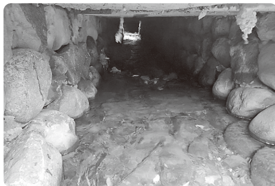
改修が必要な路面下水路の現況
