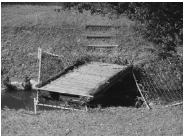
台風19号で浸水し壊れた丸塚公園の橋
