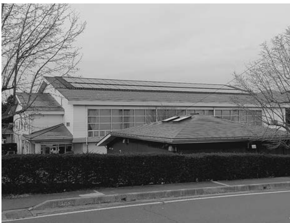
雨漏り対策が必要とされる赤穂南小学校の体育館
