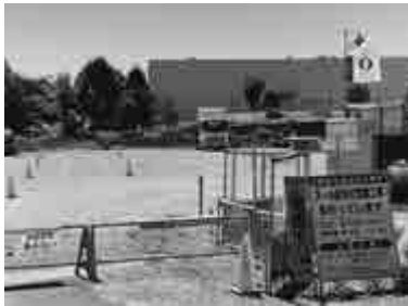
市民プール跡地も3年をかけて整備される。
