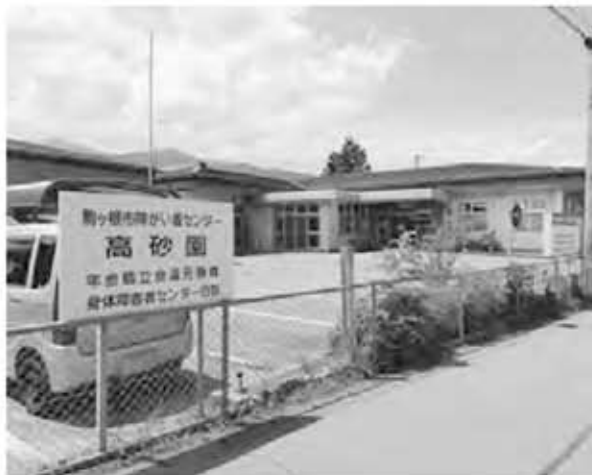
駒ヶ根市障がい者センター 高砂園 災害時には町1区の指定避難所となる
