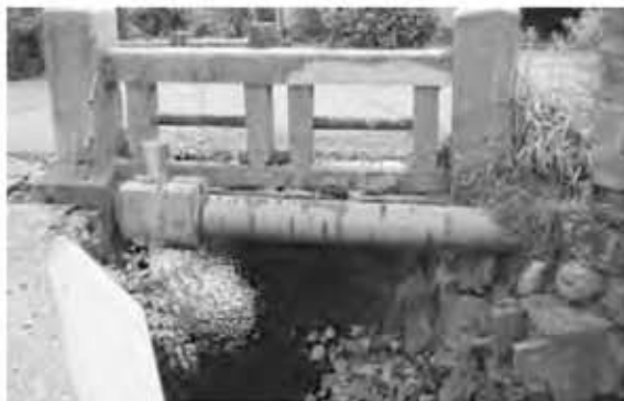
ボックスカルバートにより更新予定の「常盤橋」
