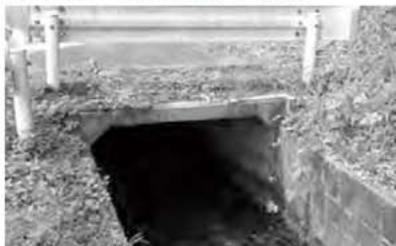
ボックスカルバートによる施工例
