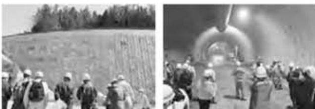
建設中の小嵐バイパスと青崩峠道路のトンネル
