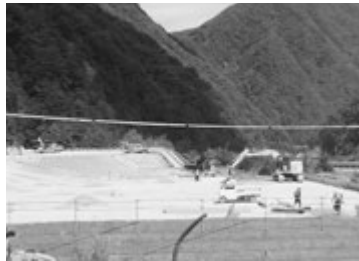
リニア発生土で造成中の大鹿グラウンド
