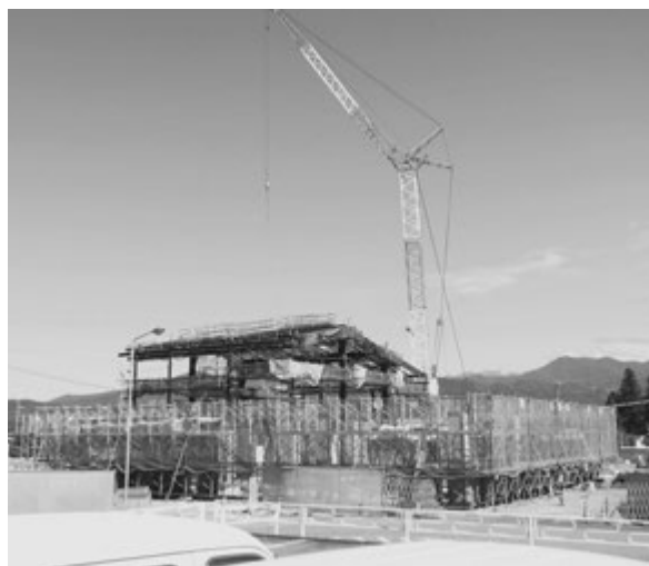
建設中の地域交流センター
