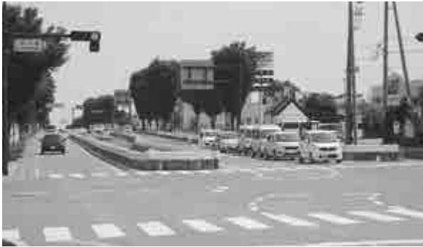
4車線化の起点となる琴平町交差点から南へ1.7km延伸
