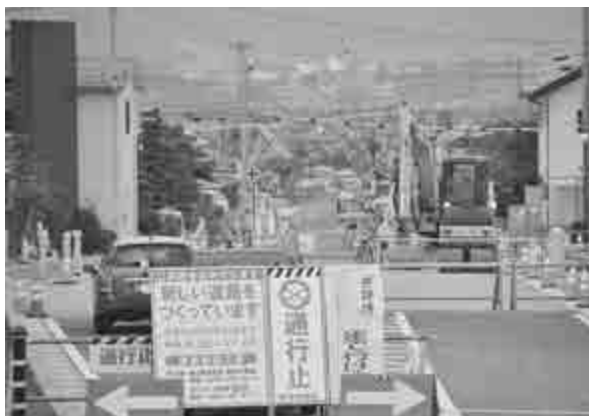
年内開通を目指して、工事が進む中割経塚線
