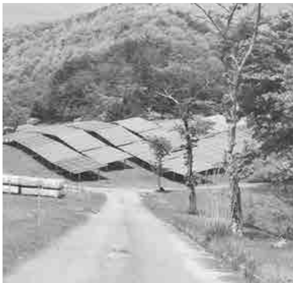
中沢区大曾倉に建設中の太陽光発電所敷地内部
