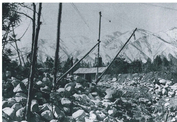
昭和 31 年 2 月赤穂上水道北原水源地（太田切川北原）
