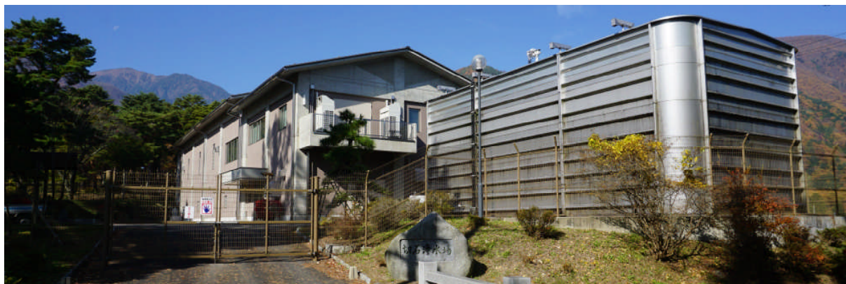
切石浄水場全景
