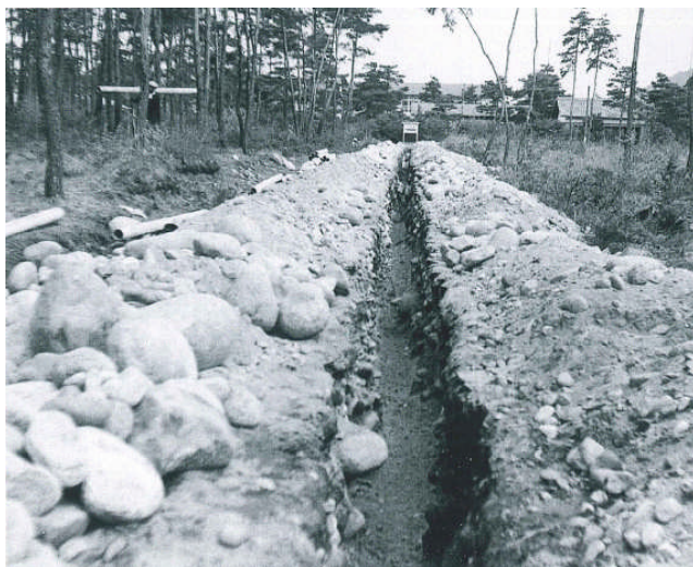
昭和34年西駒郷配水管布設 100 mm
