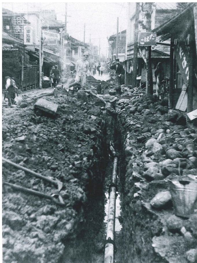
昭和31年銀座通り配水管布設 100 mm
