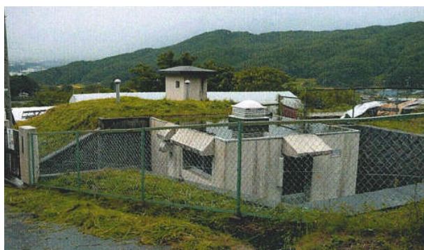
天王ポンプ室
