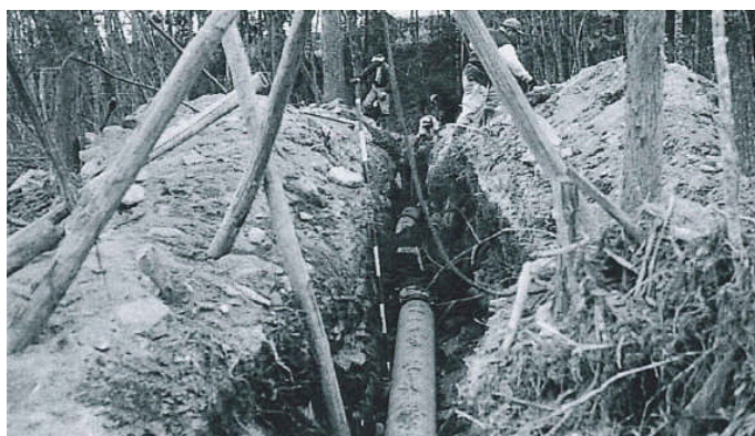
導水管布設工事
