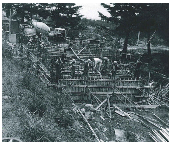
昭和40年 切石浄水場薬品沈澱池建設
