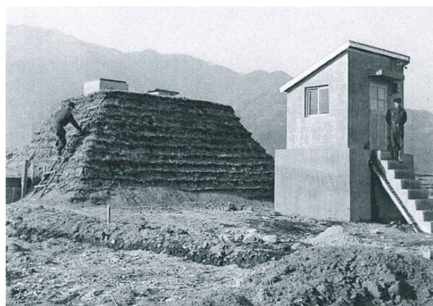
馬場配水池滅菌室
