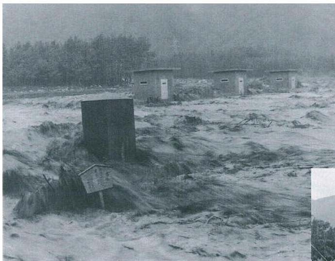
昭和 39 年 9 月 25 日 北原浄水場に流入した土石流
