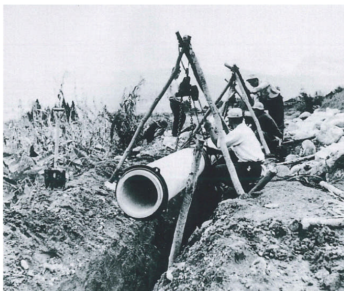
昭和 31 年 9 月馬場地区配水管布設 300 mm
