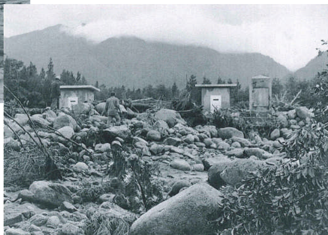
昭和 39 年 9 月 25 日午後 4 時頃 被災した北原浄水場の状況
