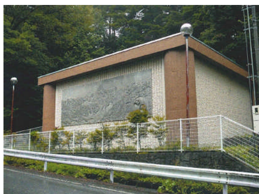
光前寺配水池
