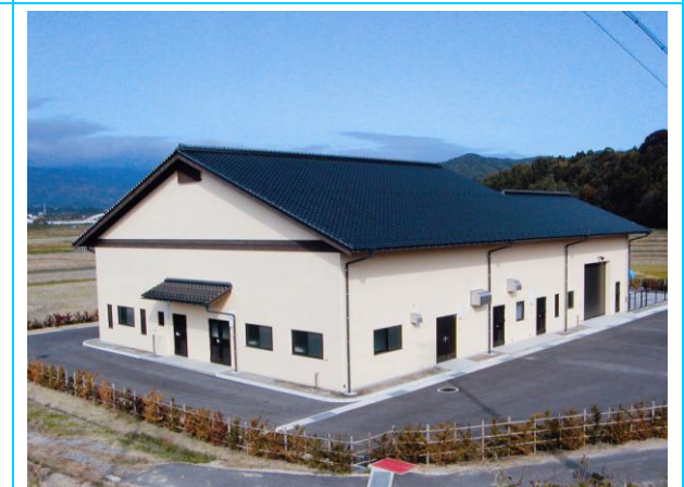
竜東中部地区浄化センター
