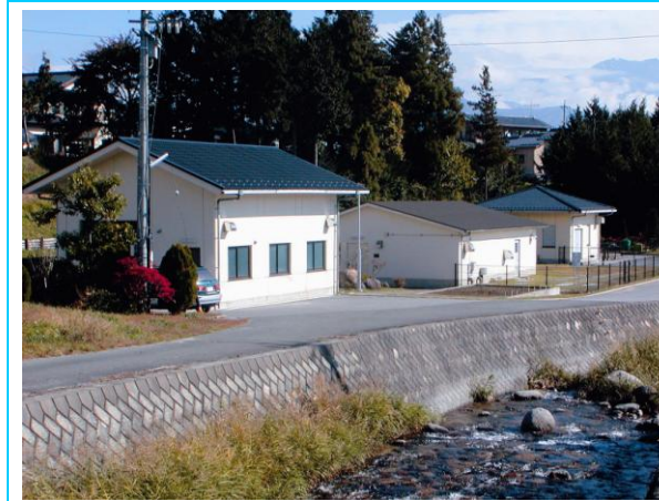
中割地区浄化センター
