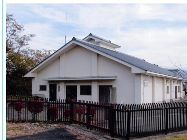
北割北地区浄化センター
