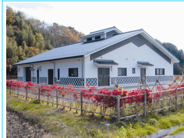
竜東北部地区浄化センター
