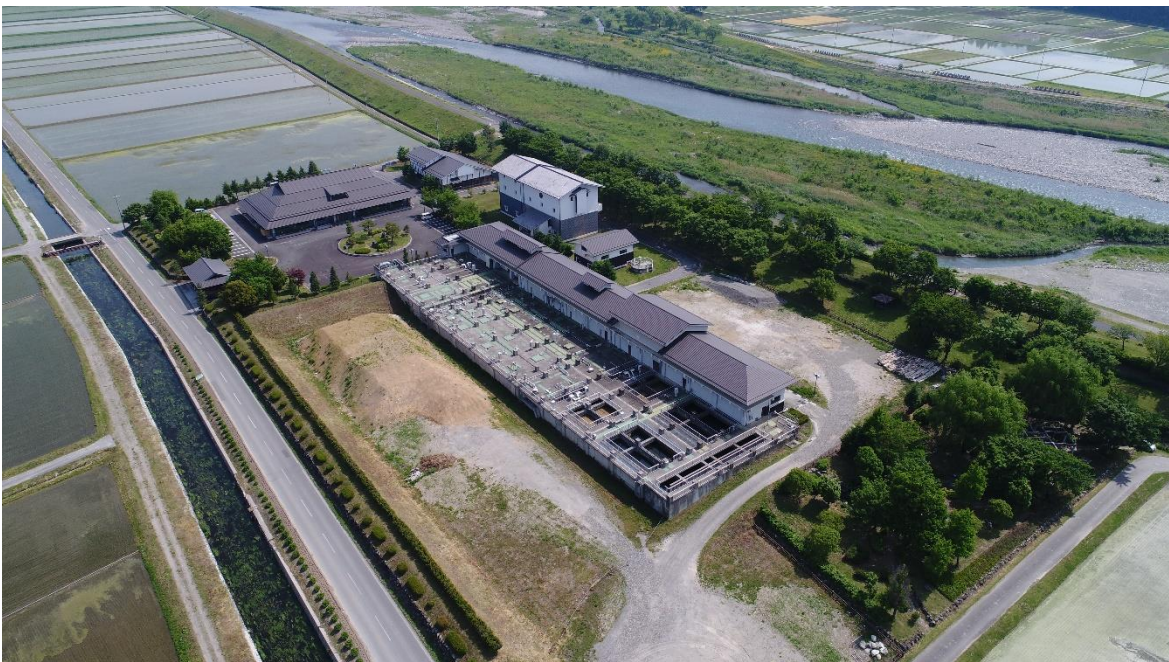
駒ヶ根浄化センター
