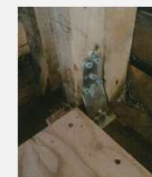
柱の金物補強
