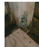
柱の金物補強
