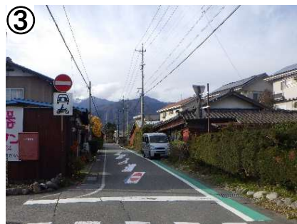
逆走防止路面標示
