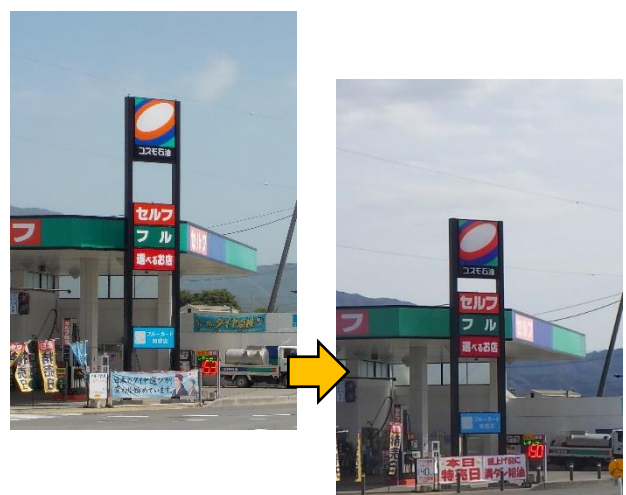
将来不適合となる既存広告物の改修 高さ11m→10mに改修（令和2年度）
