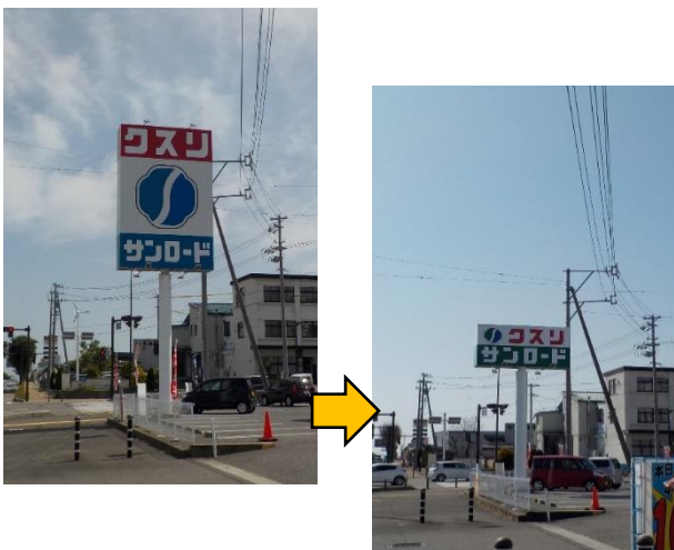
将来不適合となる既存広告物の改修 高さ12.5m→8m以下に改修（令和2年度）
