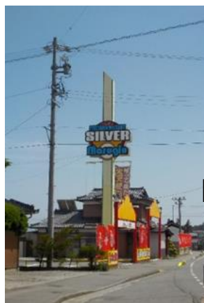
将来不適合となる既存広告物の改修 高さ14.5m→8m以下に改修
