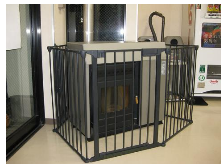
ペレットストーブの設置例
