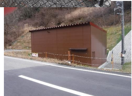
民間企業が設置した新宮川発電所
