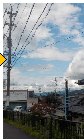
将来不適合となる既存広告物の撤去 高さ 11.2m の自己敷地内看板の撤去
