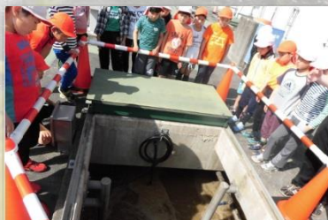
小学生による駒ヶ根浄化センターの施設見学
