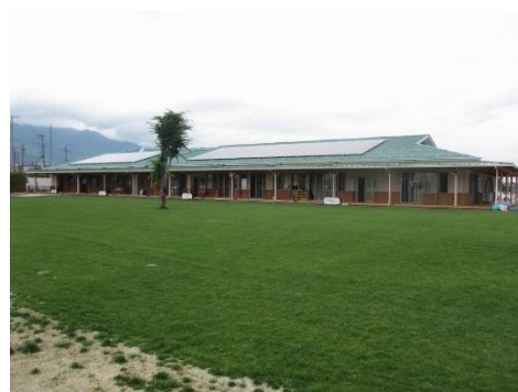
平成 28 年度に竣工した経塚保育園
