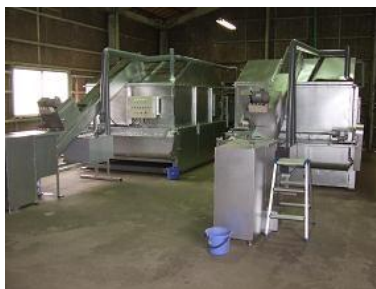
【生ゴミ堆肥化装置】
