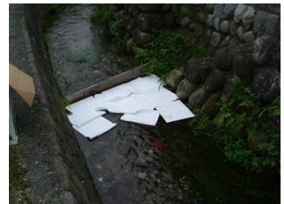
オイルマットによる油吸着作業
