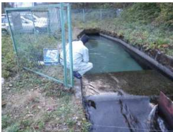
写真 3.1 取水地点上流側状況
