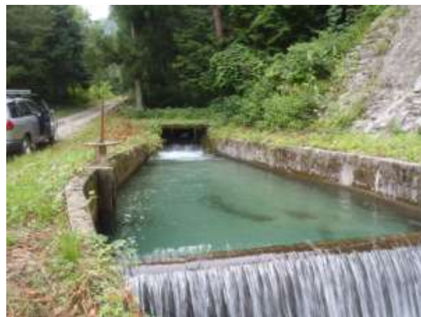
写真 3.1 分水工 発電所設置位置下流側
