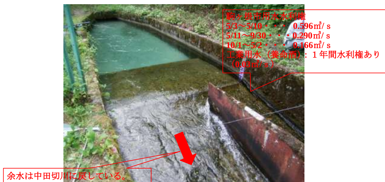
写2.1 分水槽の流況状況
