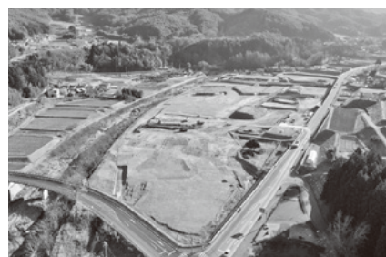
工事中新宮川岸交差点付近
