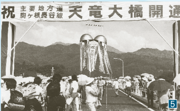
▲歩道を備えた二車線の天竜大橋開通
