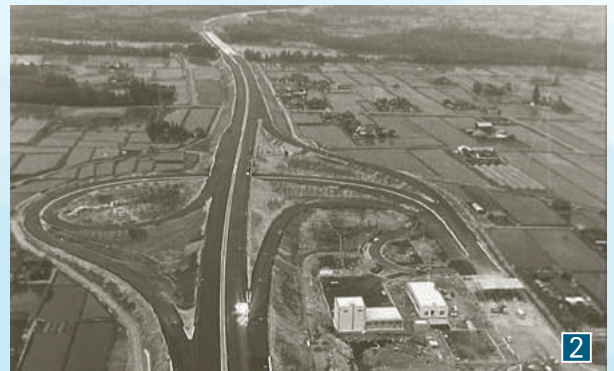
▲建設が進む中央自動車道駒ヶ根インター
