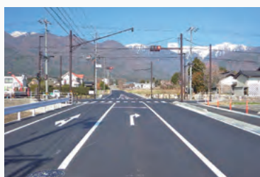
通学路交通安全施設整備 (市道光前寺南線など) 2億8,095万円
