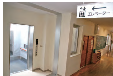
赤穂中学校エレベーター設置工事 4,110万円
