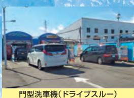
門型洗車機(ドライブスルー)
