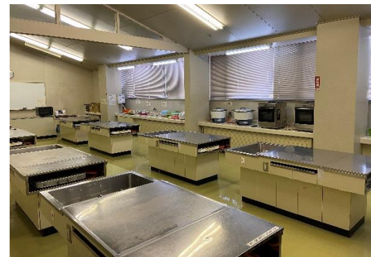
【空調設備未設置の料理実習室内】
