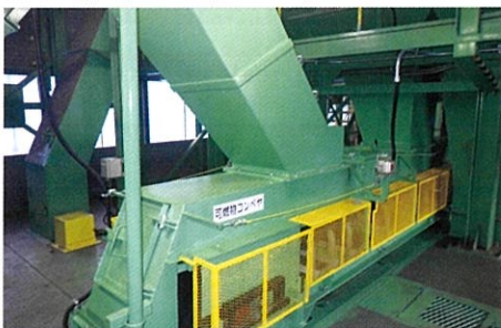
搬送装置更新(可燃物コンベヤ)
