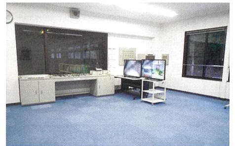
中央操作室(操作盤更新、床張り替え)
