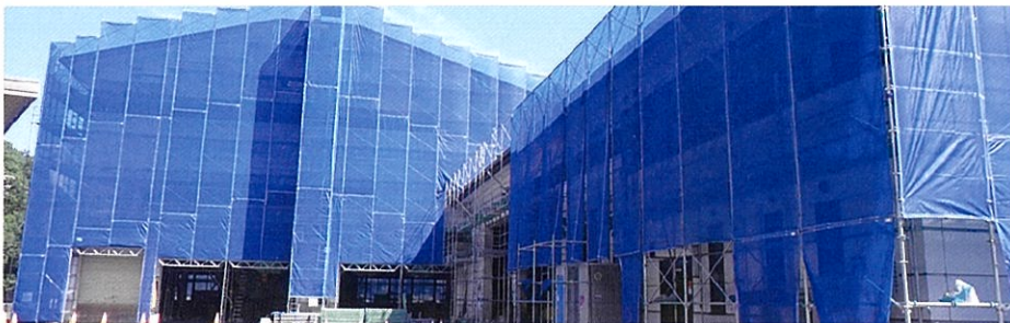
9月、11月、2月はごみの受け入れを休止して工事を行いました
