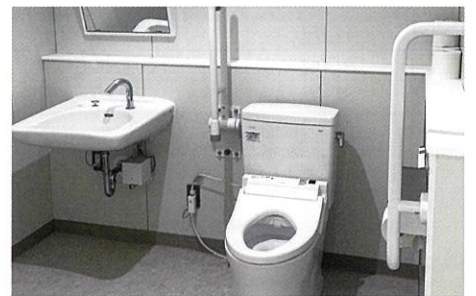
管理棟内部改修(多目的トイレ新設)
