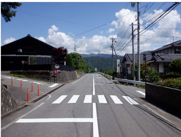
白線引直し・カーブミラー盤取替 （市道小鍛冶線、美女ヶ森付近）
